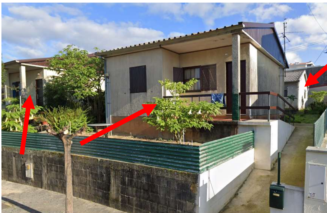
Fotografia 5– Localização de três unidades de ocupação pertencentes ao município situadas na Rua Dr. Acácio Azevedo.
