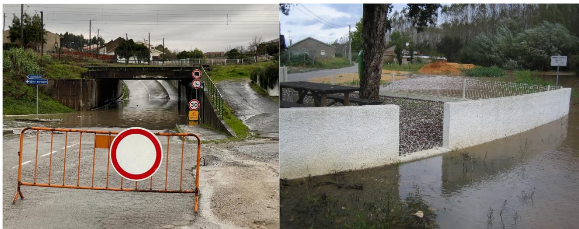
Figura 150 - Inundação em Oliveira do Bairro
