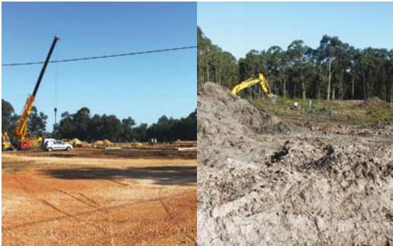
OBRAS | PÓLOS ESCOLARES DE OIÃ POENTE E VILA VERDE
