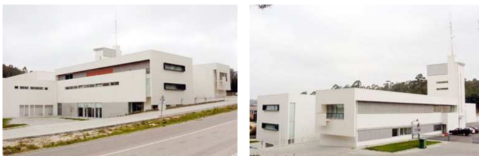
Figura 20 – Quartel dos Bombeiros Voluntários de Oliveira do Bairro
