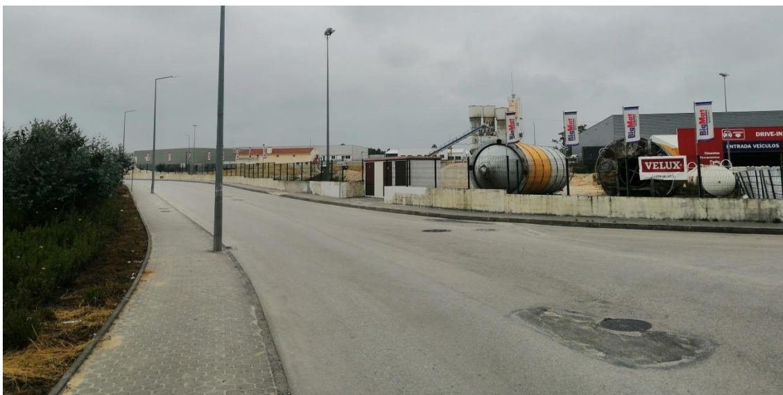
Fotografia 3 - Vista parcial do traçado da EM 596-3 (Rua G), na envolvente próxima da EM 596 (sentido sul-norte)
