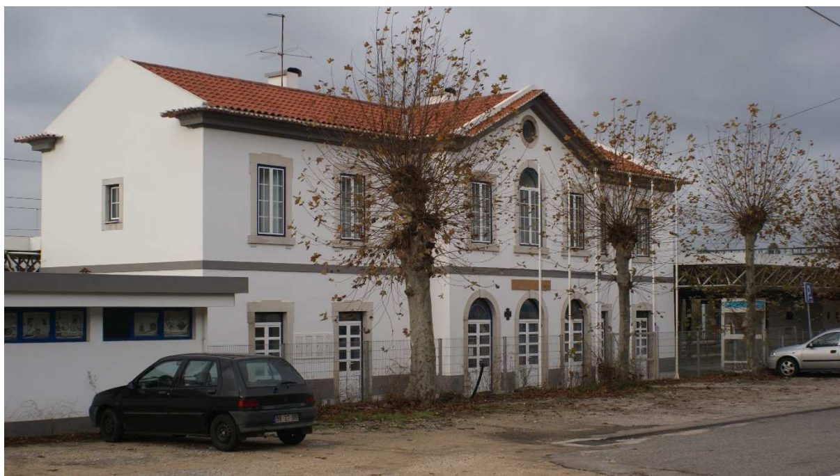
Fotografia 5 - Estação de caminho de ferro de Oliveira do Bairro
