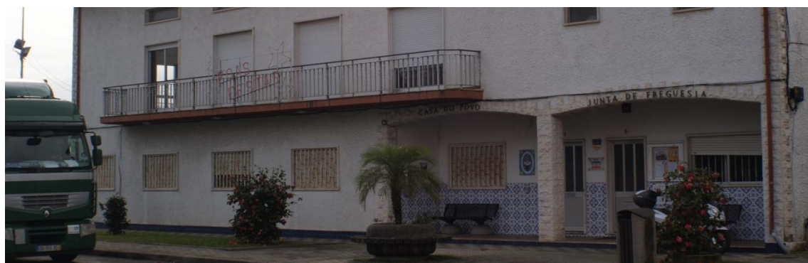
Figura 35 – Edifício da Junta de Freguesia
