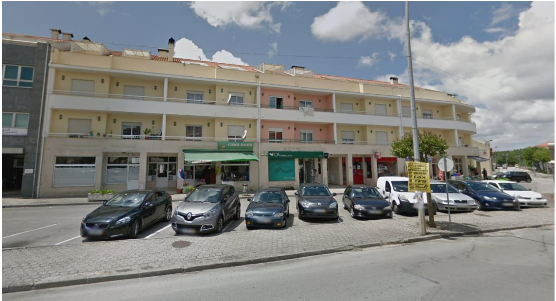
Fotografia 3 - Vista parcial da EM 335 e da estrutura edificada envolvente
