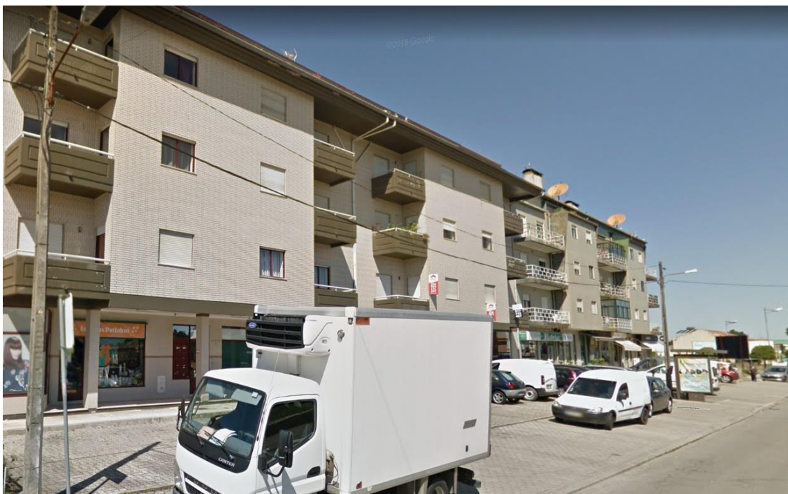
Fotografia 3 – Vista parcial do traçado da EM 335 e da estrutura edificada envolvente
