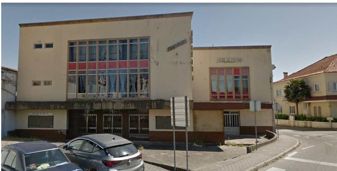
Fotografia 2 – Edifício do antigo Cinema de Bustos
