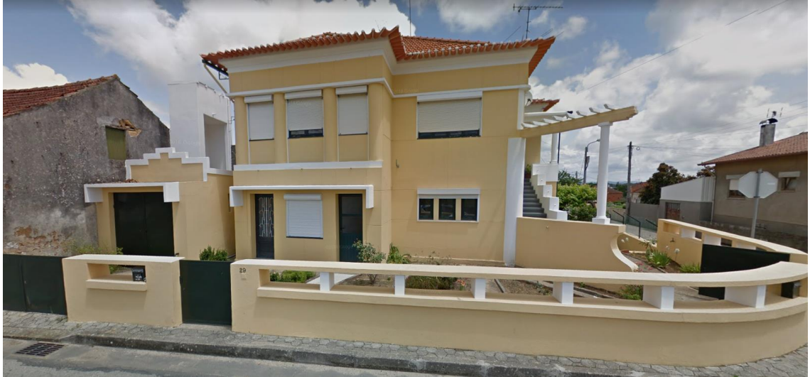
Fotografia 2 - Edifício de habitação unifamiliar – Rua Jaime Pato
