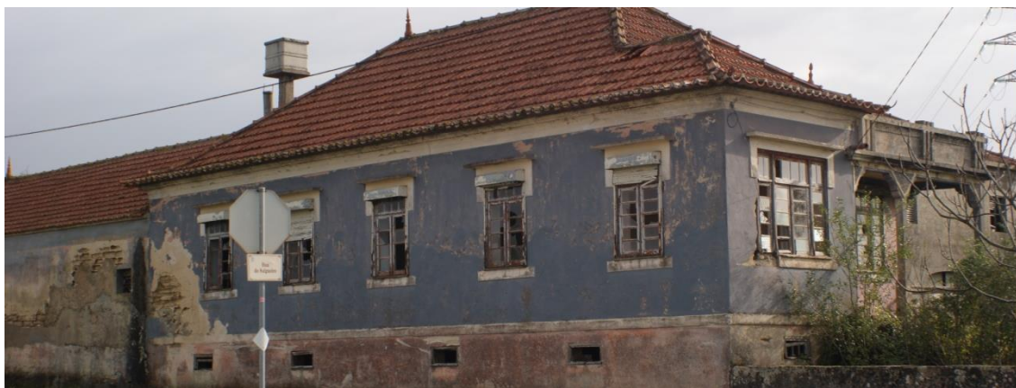
Figura 31 – Edifício no centro urbano da Mamarrosa
