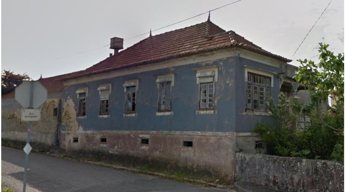
Fotografia 2 – Edifício de habitação unifamiliar
