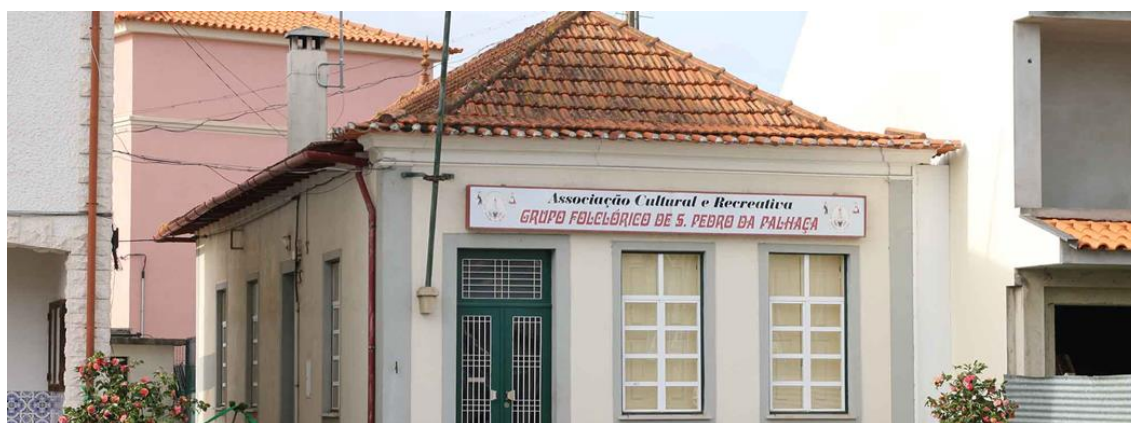
Figura 30 – Antigo edifício do Correios da Palhaça
