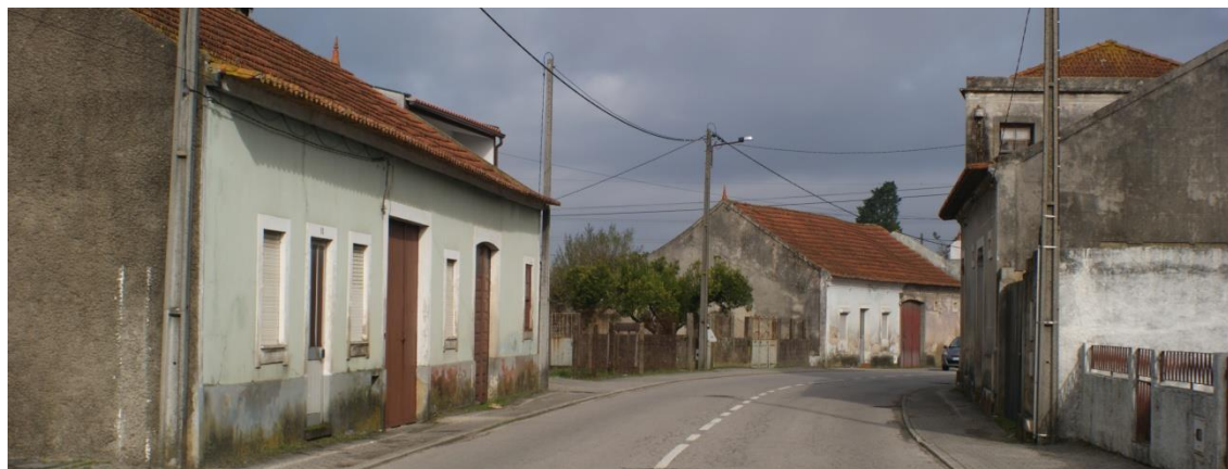
Figura 36 – Edificado em mau estado de conservação
