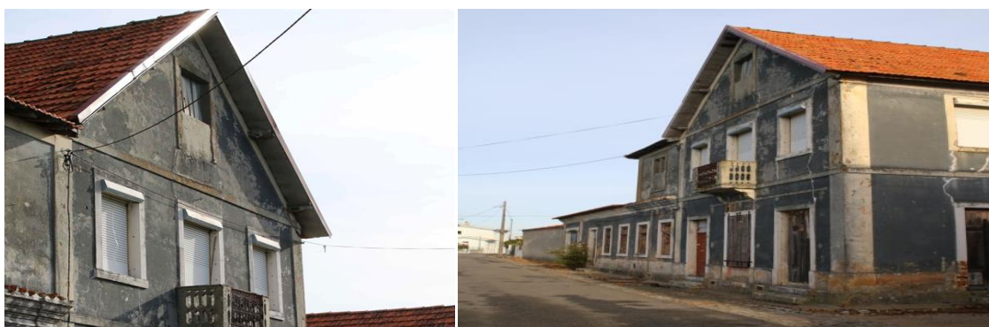
Figura 40 – Edifício do antigo 'Hotel Comercial', em mau estado de conservação
