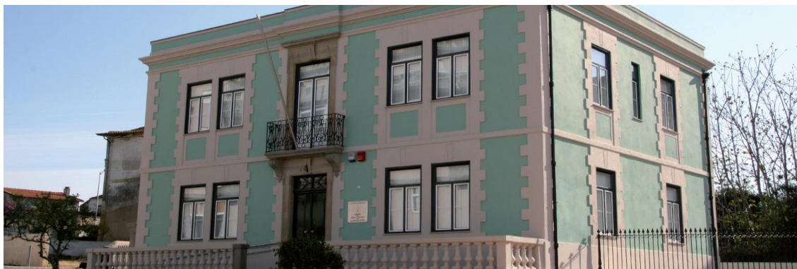
Figura 26 – Edifício ‘Casa Verde’, reabilitado para albergar o Tribunal de Família e Menores do Baixo Vouga
