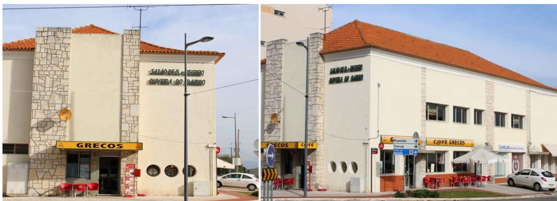
Figura 35 – Edifício do antigo Salão de Baile e Beneficência
