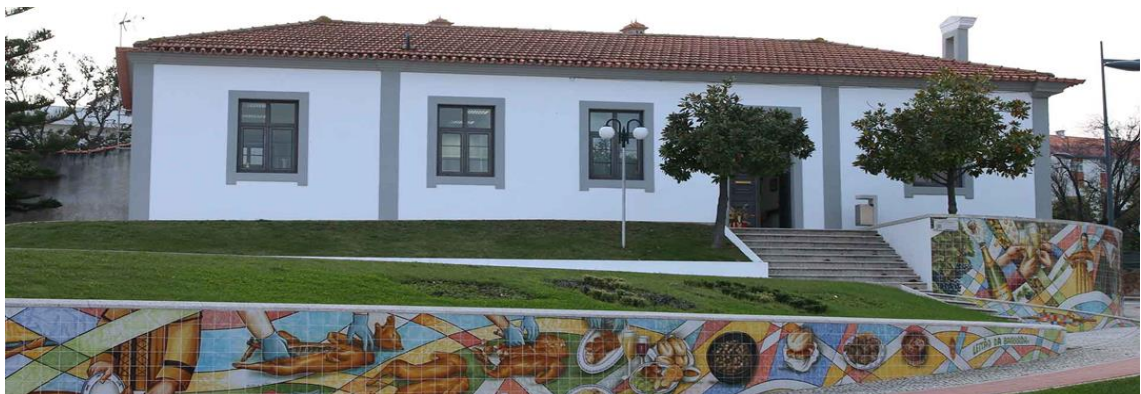
Figura 38 – Edifício da antiga escola primária, reabilitado para albergar a Junta de Freguesia de Oliveira do Bairro
