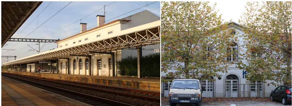
Figura 31 – Estação da CP OLIVEIRA DO BAIRRO
