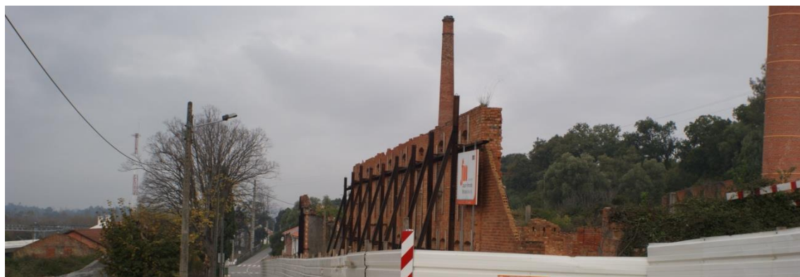
Figura 25 – Complexo da Fábrica 'Cerâmica Rocha' [em obra]
