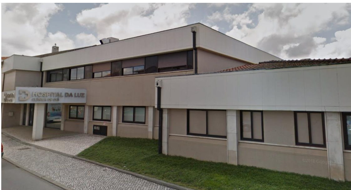
Fotografia 4 – Hospital da Luz – Clínica de Oiã
