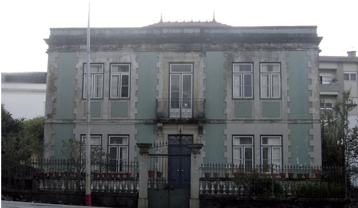
Imagem 10 – Casa Verde antes das obras de remodelação
