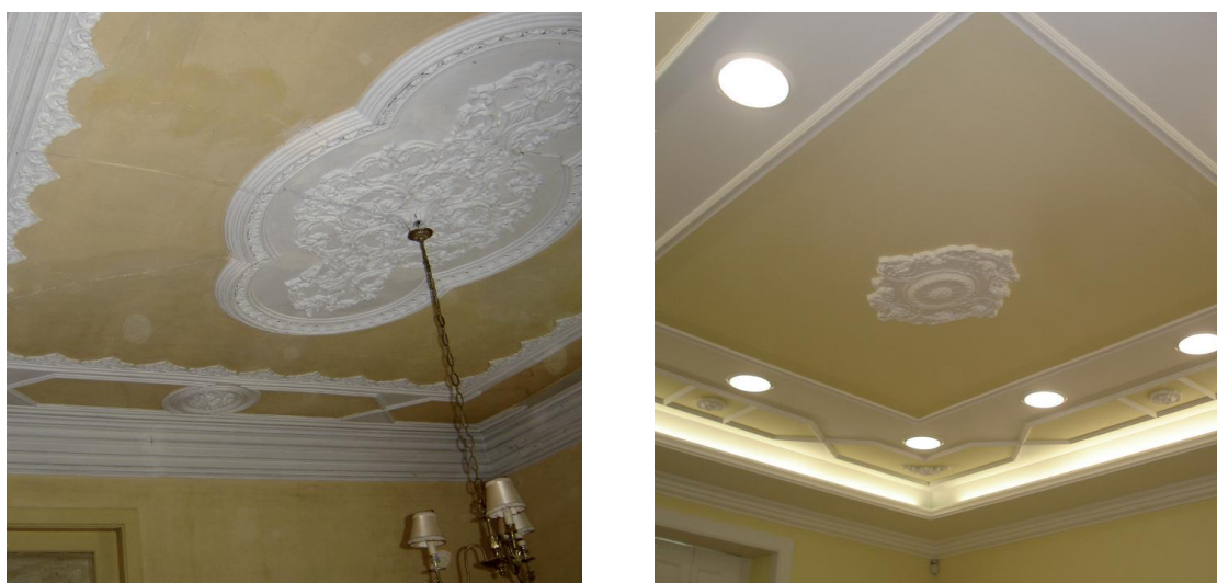
Imagem 8 e 9 – Imagens da recuperação dos tetos existentes
