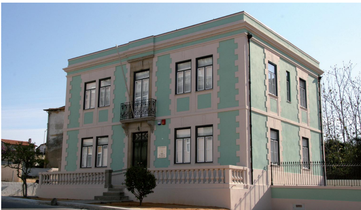
Imagem 11 – Casa Verde depois das obras de remodelação
