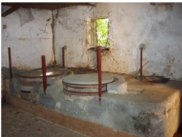
Imagem 14 – Zona das Moagens – sala 1
