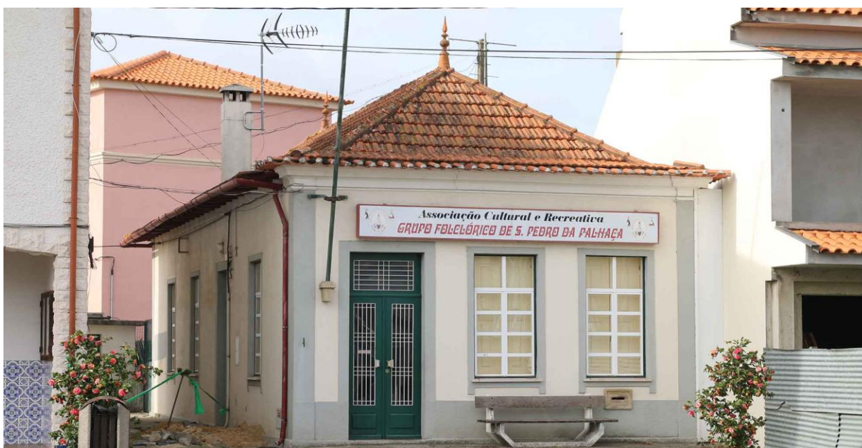
Imagem 88 – Antigo edifício dos Correios da Palhaça
