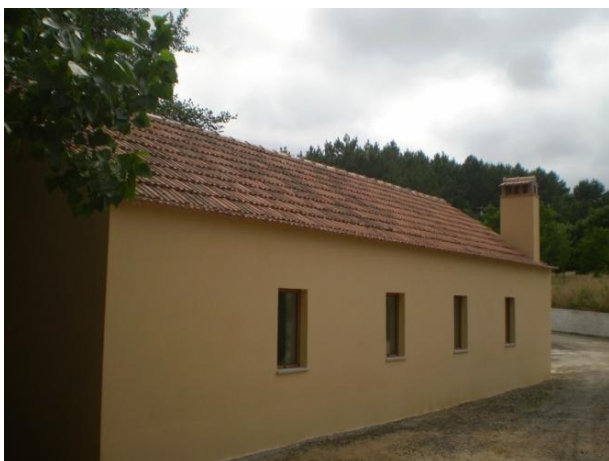
Imagem 17 – Alçado principal NE
