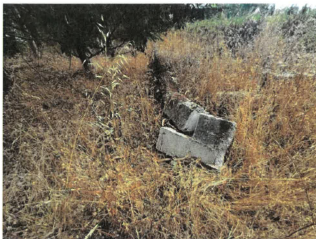
Imagem nº9 – Muro de delimitação na confrontação a sul que pertence ao prédio confrontante
